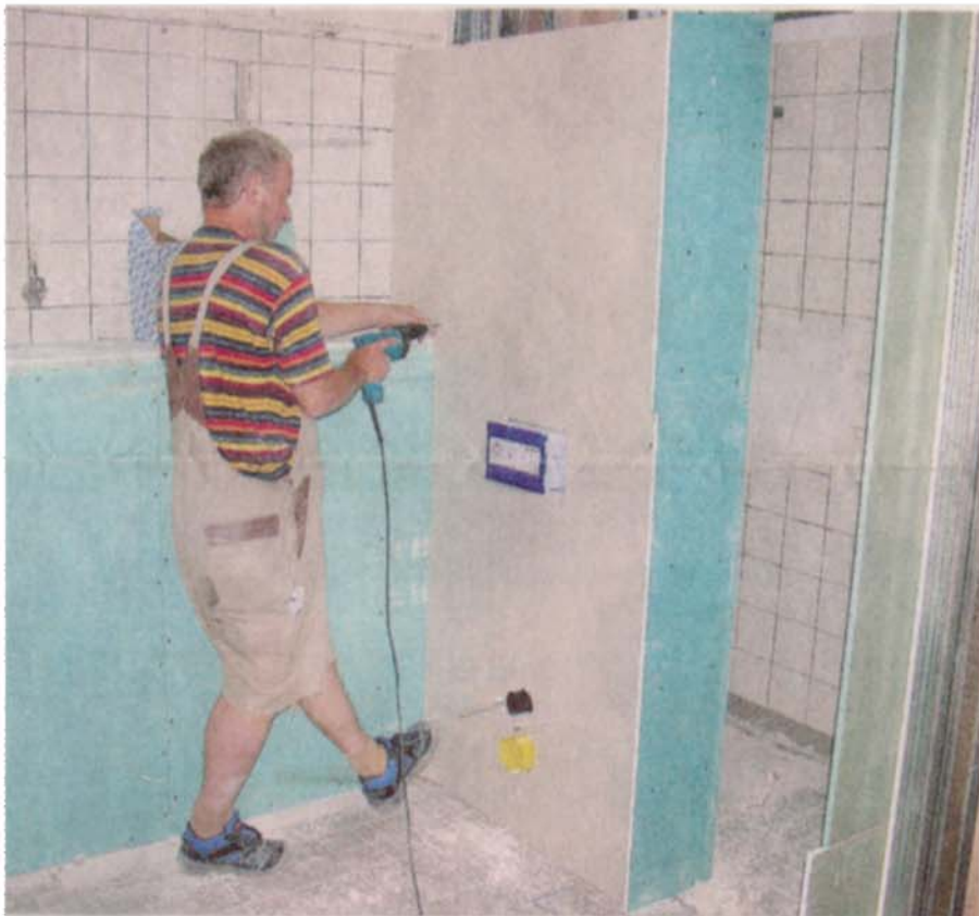
Bis zum Schuljahresbeginn müssen die neuen Sanitäranlagen installiert sein. Für Eltern, Mitglieder des Waldorf-Vereins und BRAS-Mitarbeiter gibt es noch viel zu tun.
