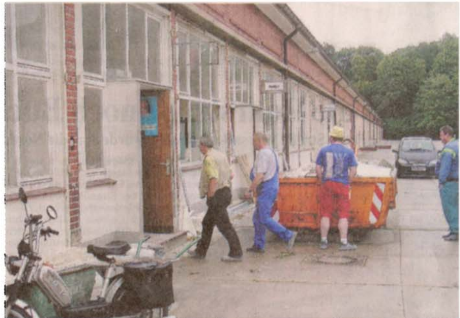
In dieses ehemalige Kasernengebäude auf dem Gelände der IUB zieht die Waldorfschule Bremen-Nord ein. Die Umbauarbeiten sind angelaufen. FOTOS: NIKLAS ZIEGLER
