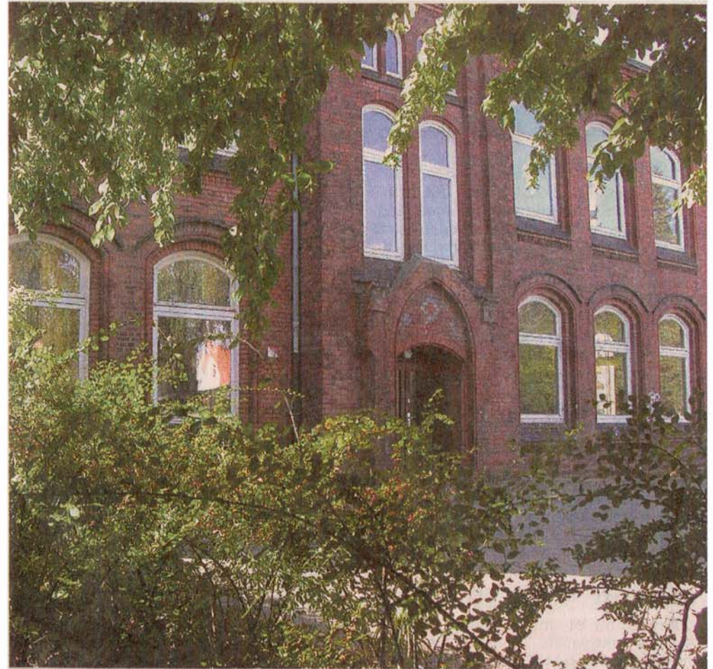
In diesem ehemaligen Schulgebäude an der Friedrich-Humbert-Straße wird wohl im Sommer 2006 der Unterricht der Freien Waldorfschule Bremen-Nord beginnen. FOTO: BAHR
